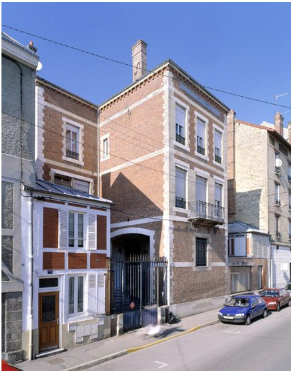
Vue d'ensemble, depuis la rue.
