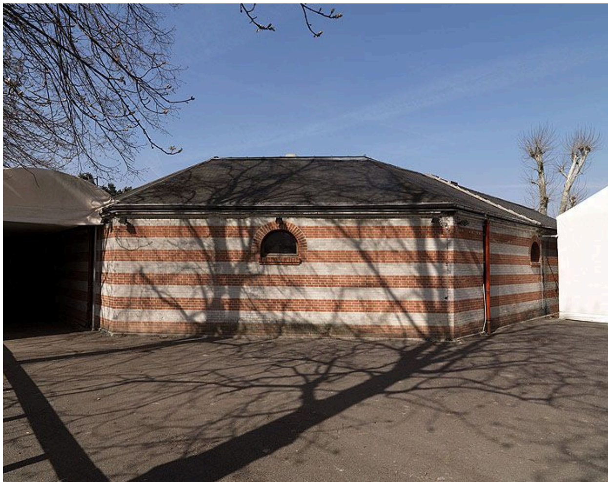
92, Rueil-Malmaison, hippodrome de Saint-Cloud, rue de la Fouilleuse. Infirmerie des chevaux.
