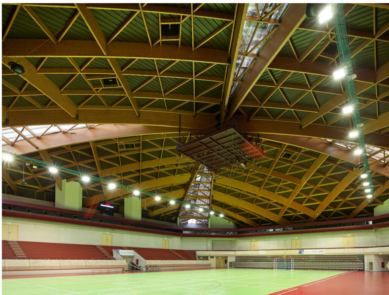
Le palais omnisports de la ville de Thiais. Salle omnisports.
