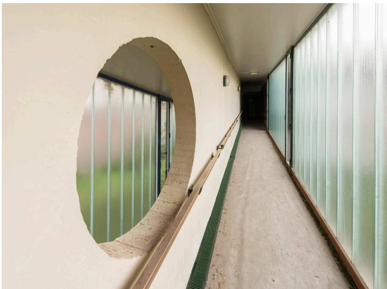
Détail d'une ouverture en hublot dans la passerelle sud-est conduisant aux logements.
