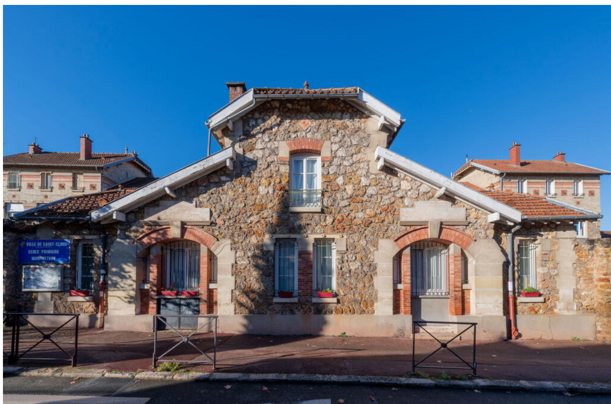
École Élémentaire de Montretout, pavillon d'entrée
