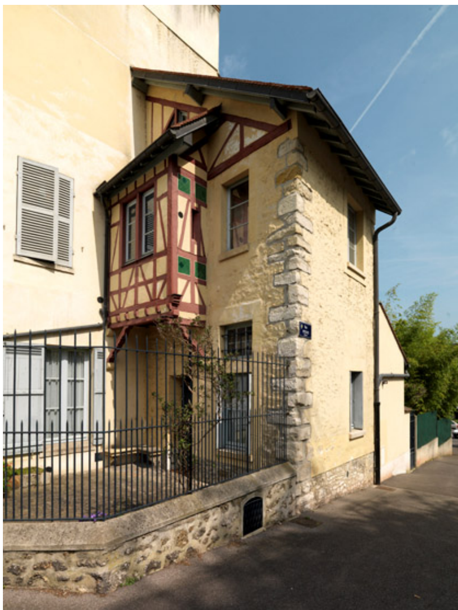
Hôtel, 14 rue Notre-Dame. Détail de l'adjonction.
