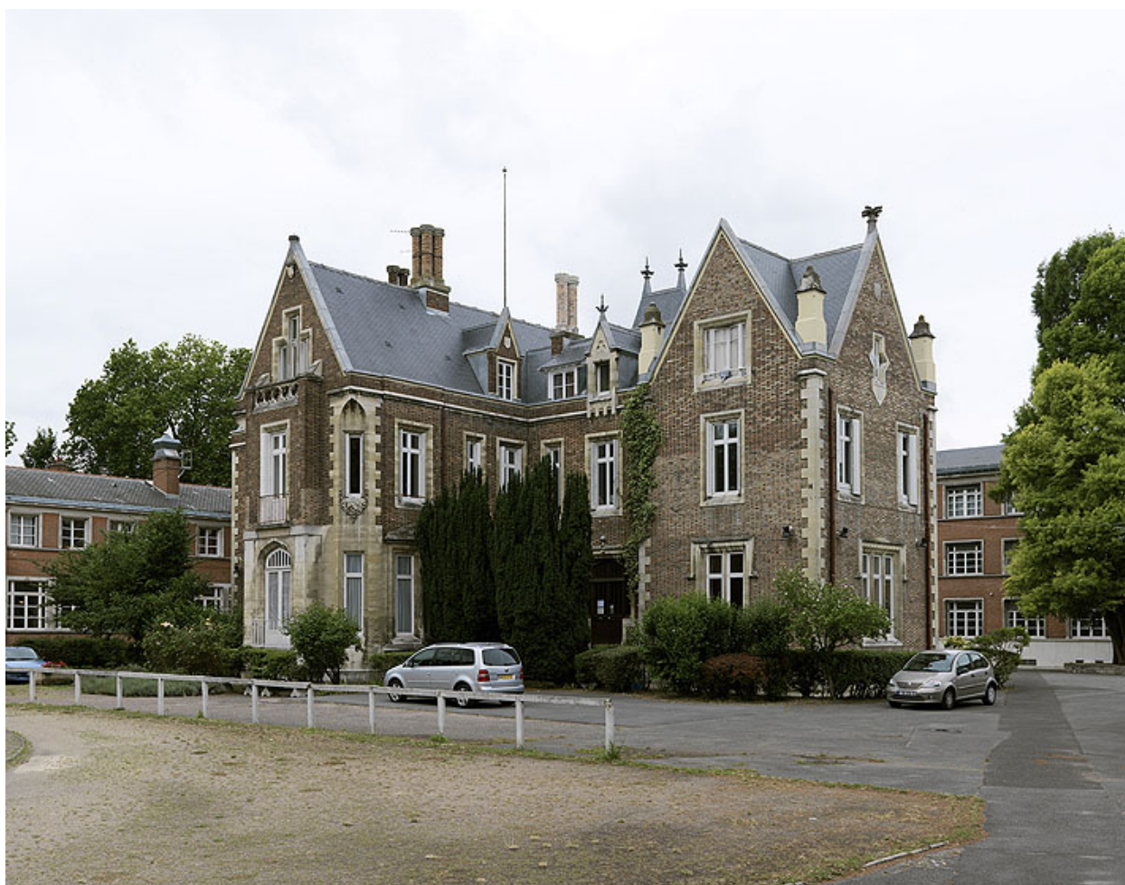
Vue en perspective des façades vers le lac et latérale.
