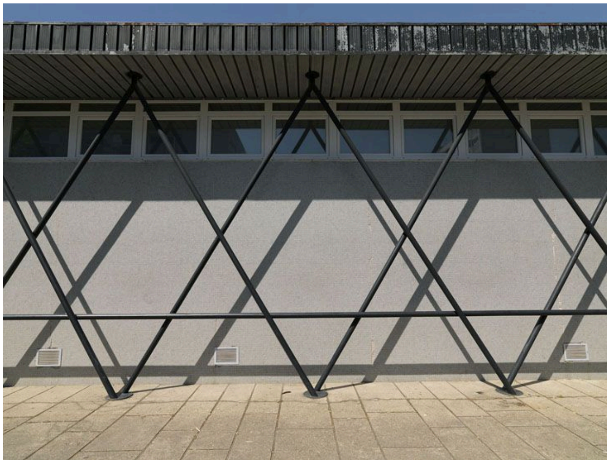
Détail de la façade.
