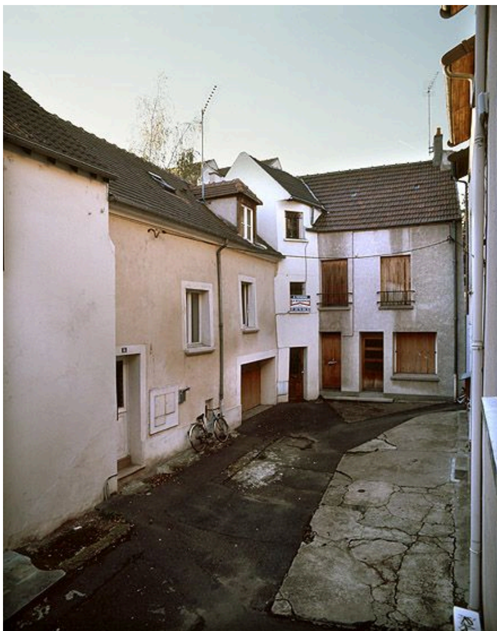
Vue de la façade est de la cour : détail.
