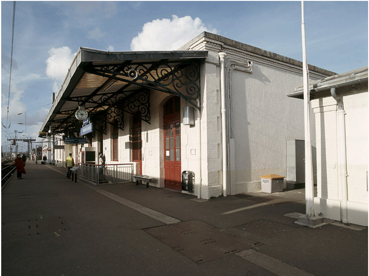
La marquise du côté du quai.
