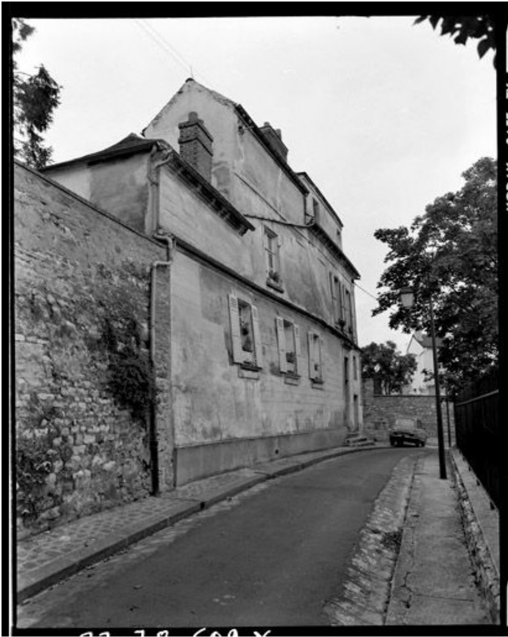
Maison, Abbé-Hua (rue de l') 10. Vue sur le square du château.
