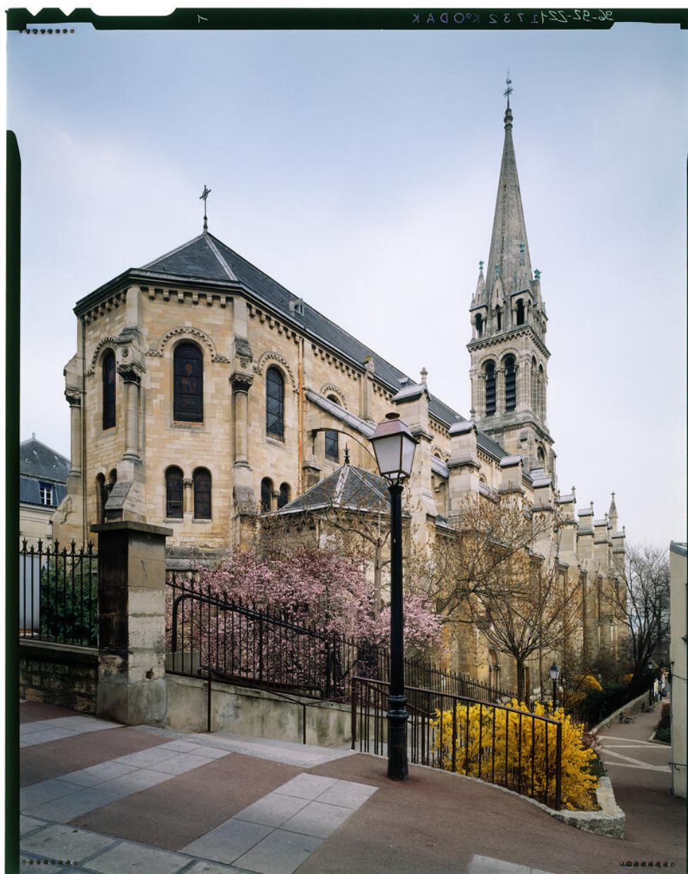
Eglise Saint-Clodoald, vue du chevet
