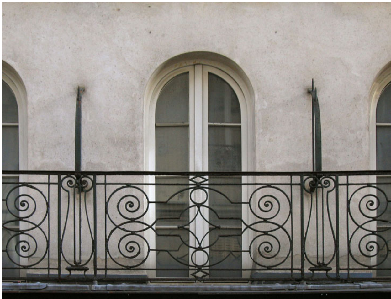
Détail d'un panneau du balcon, 39-41, rue de Cléry.
