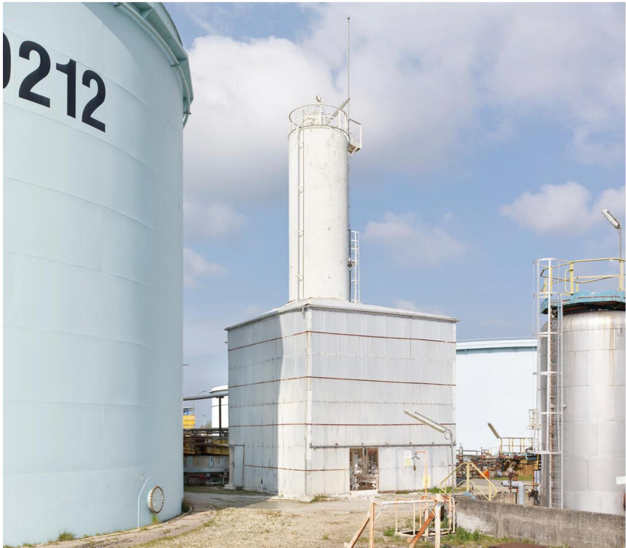
Zone du traitement des eaux (Unité 420). Local à chaux, produit chimique utilisé pour les décarbonateurs et pour faire remonter le pH de l'eau traitée.
