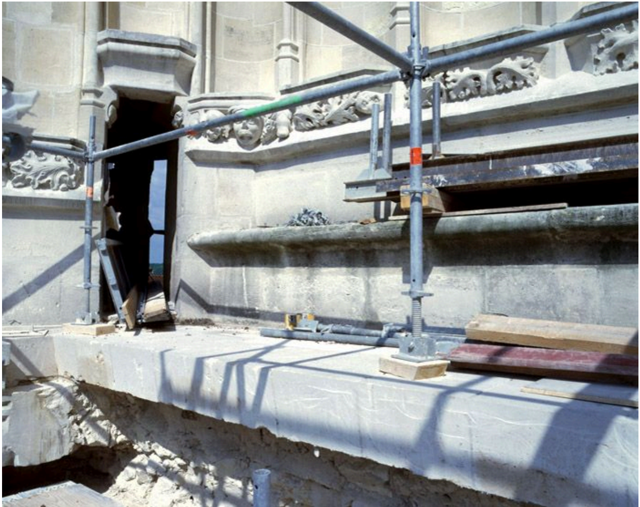
La façade occidentale : vue du chantier de restauration de la base de la tour nord (2008). Détail de la galerie de circulation supérieure.
