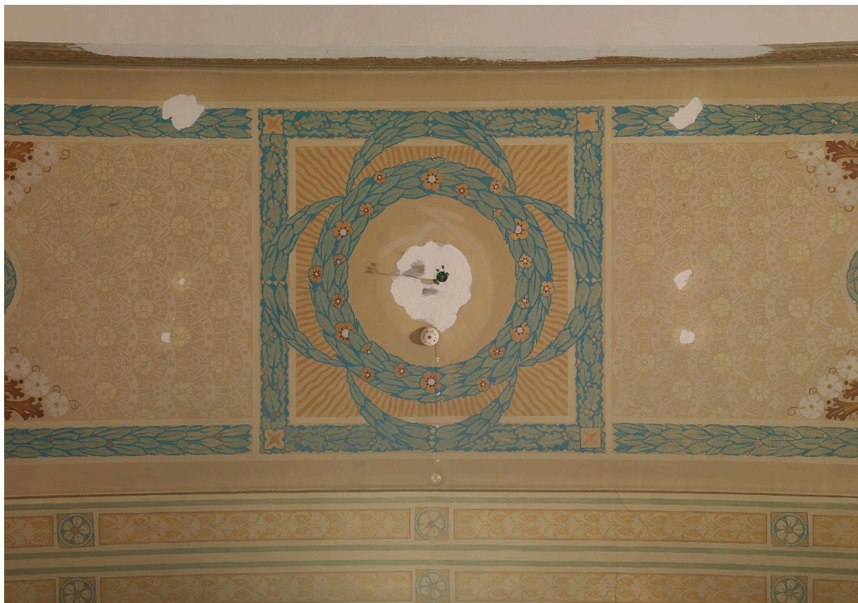
Mur nord, décor de la travée témoin et de l'arc : partie centrale.
