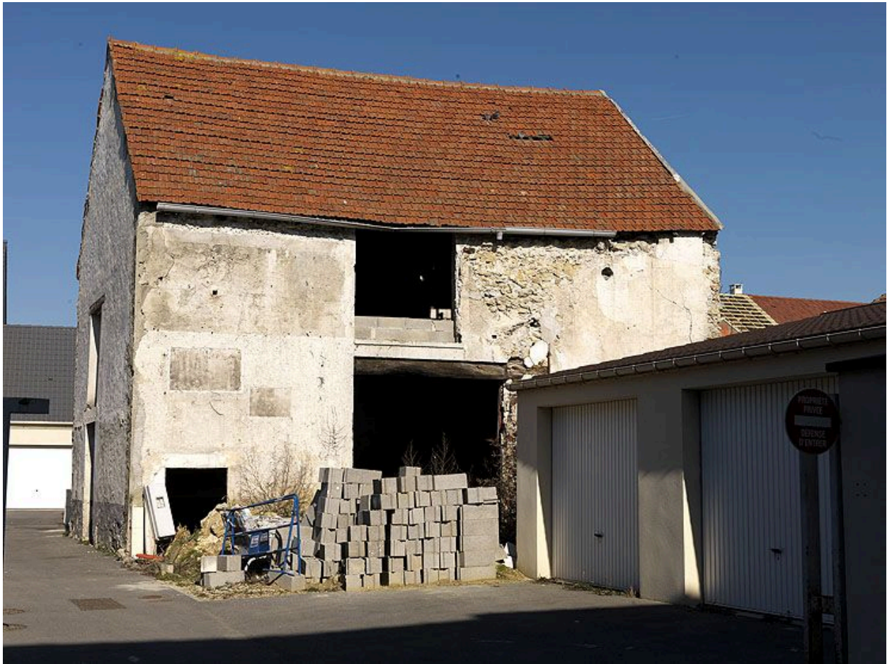
Ancienne grange dans la cour du 147, rue du Faubourg Saint-Nicolas.
