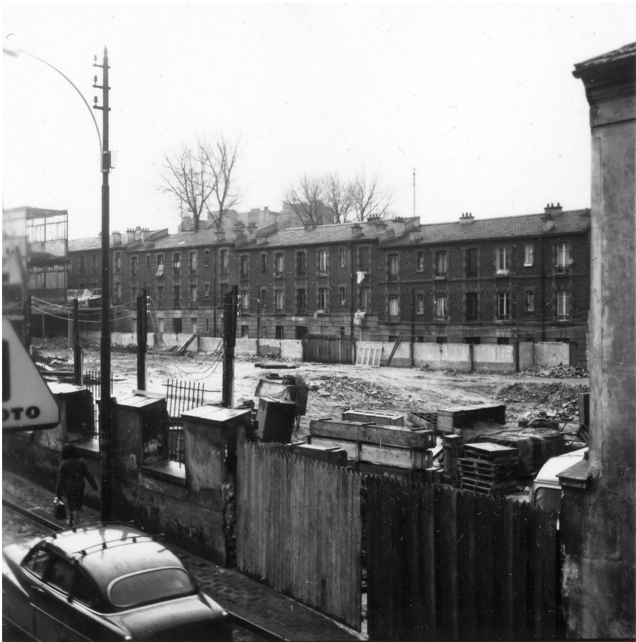
La cour de l'usine Kalker après le démolition de la chaufferie et d'une partie des ateliers, 1968 (coll. Jean Huret).
