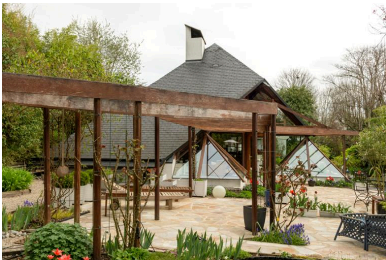
Vue de la façade latérale gauche : pergola allant du bassin jusqu'à la maison
