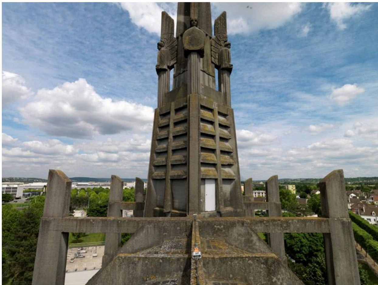
Extrados de la voûte et départ de la flèche de l'église.
