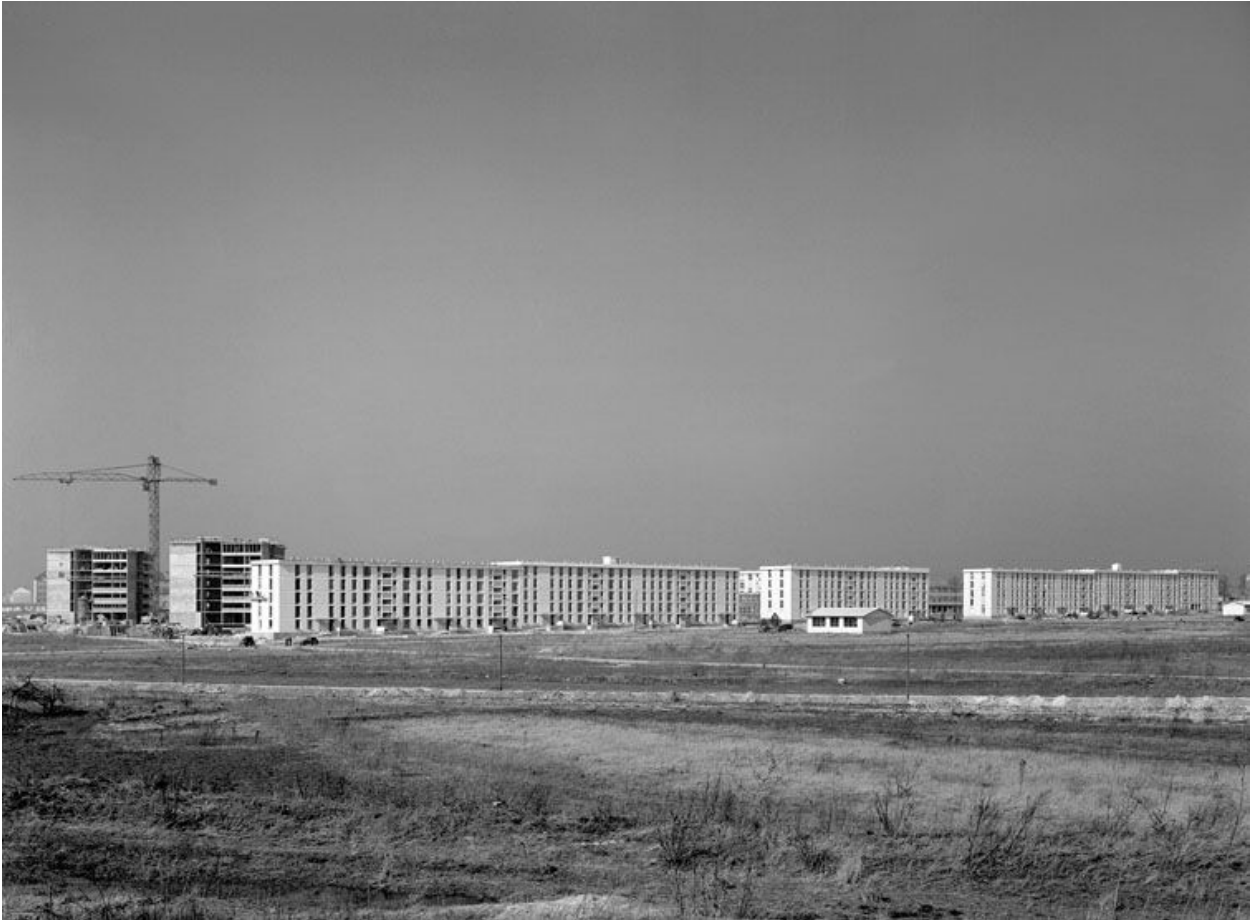
Le chantier de construction. Photographie, 1961. (Ministère de l'Ecologie, MRU 36808002)
