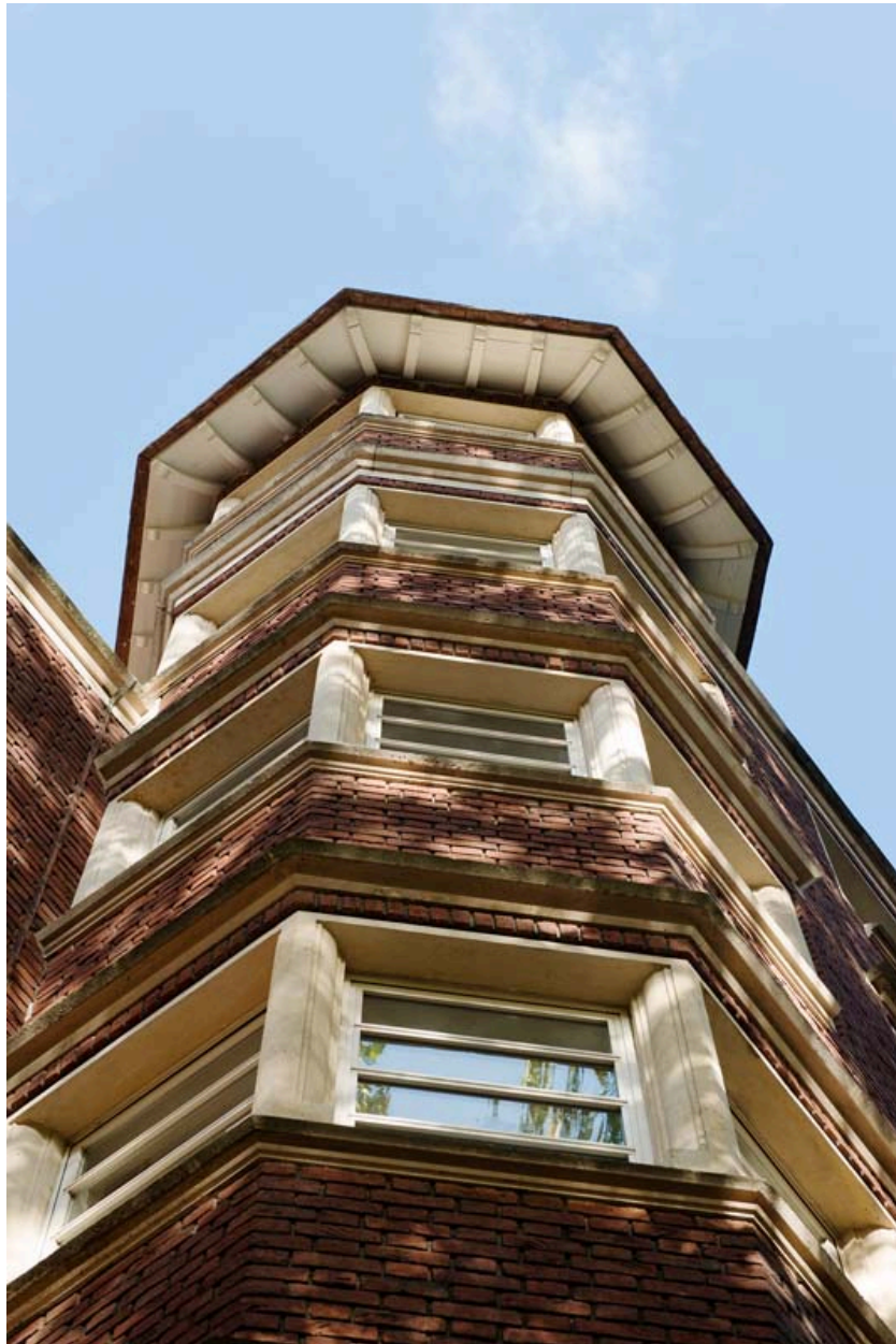
Tourelle à l'angle sud-est du bâtiment.
