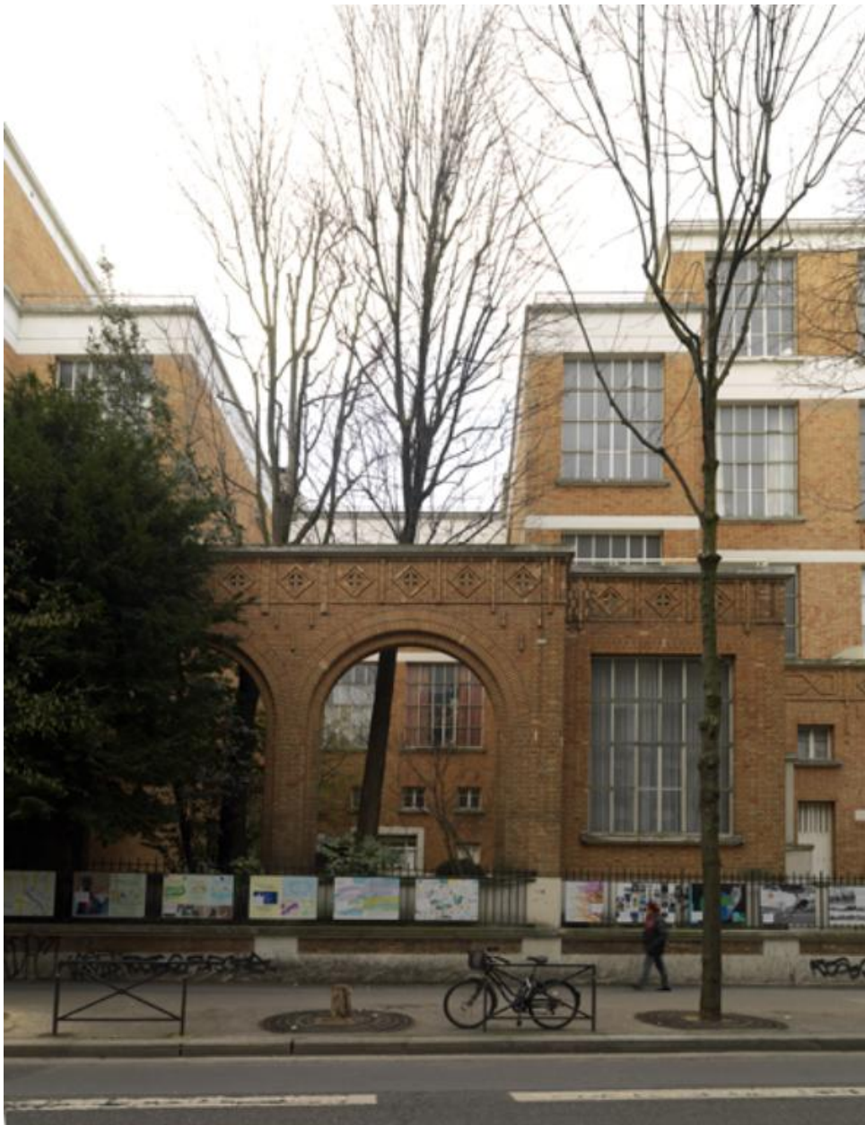
Vue de l'extrémité gauche de la façade principale
