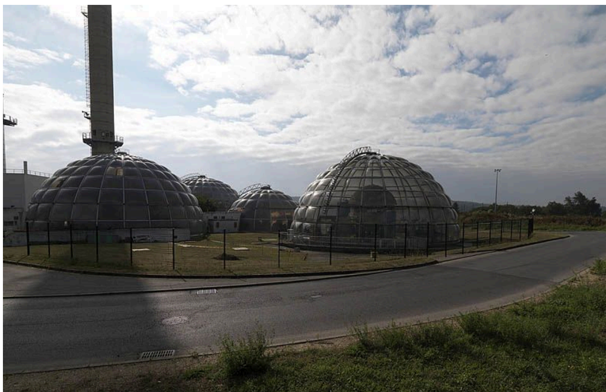
Vue d'ensemble de la chaufferie, depuis le nord-est.
