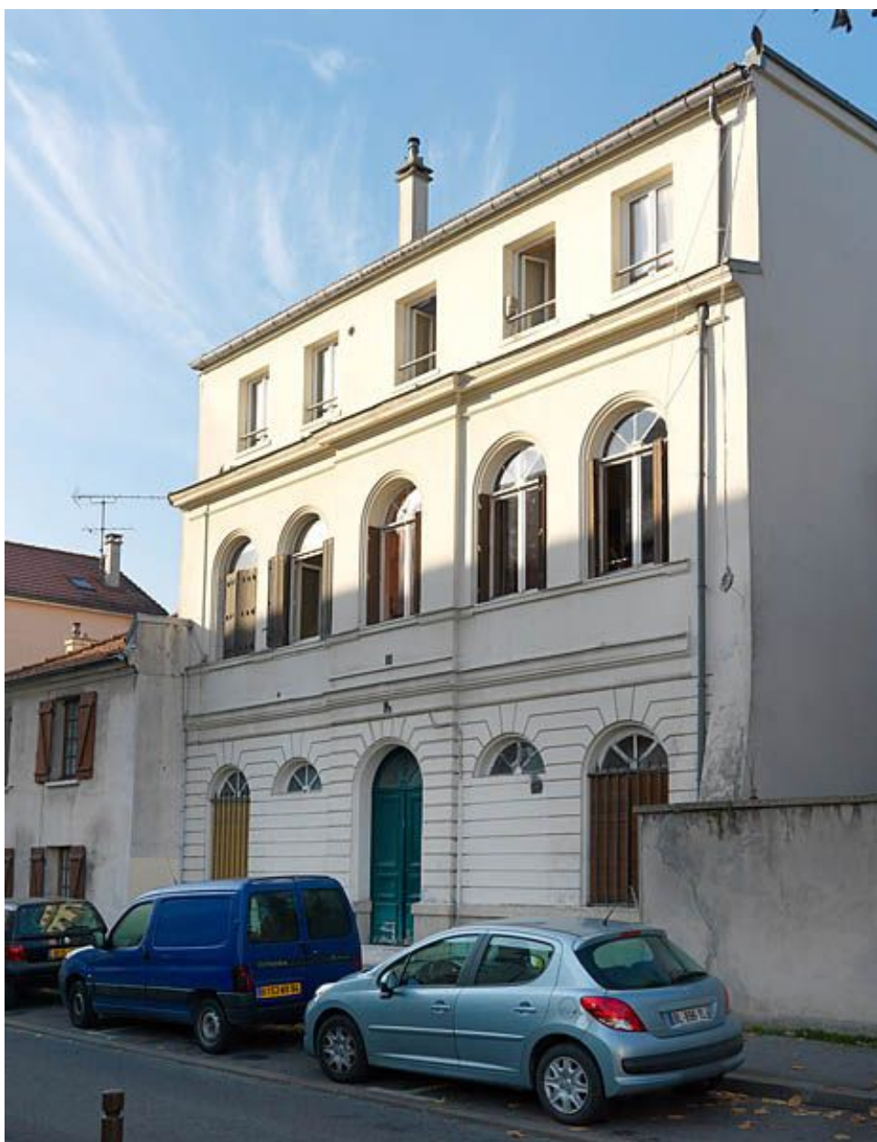
Chevilly-Larue, maison, 5 rue de la Bergère. Vue d'ensemble.
