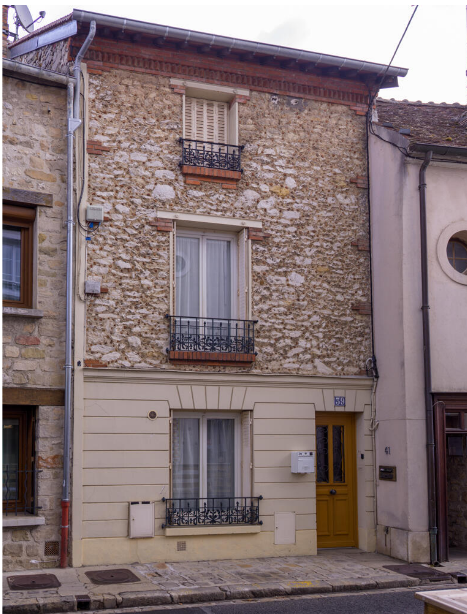
Vue générale depuis le sud.
