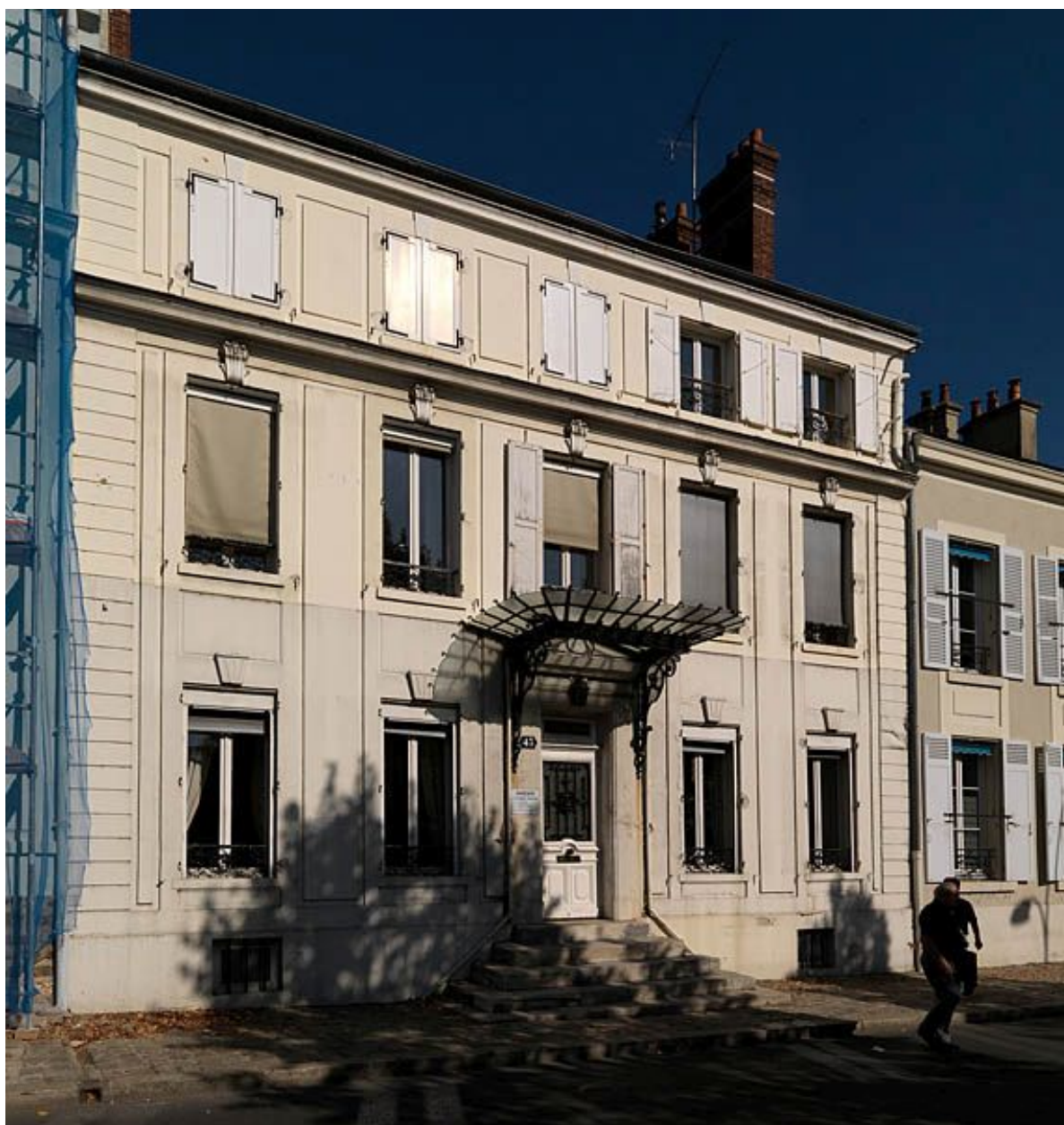
Immeuble à attique au 43, boulevard Jean-Rose. L'entrée est magnifiée par la marquise.
