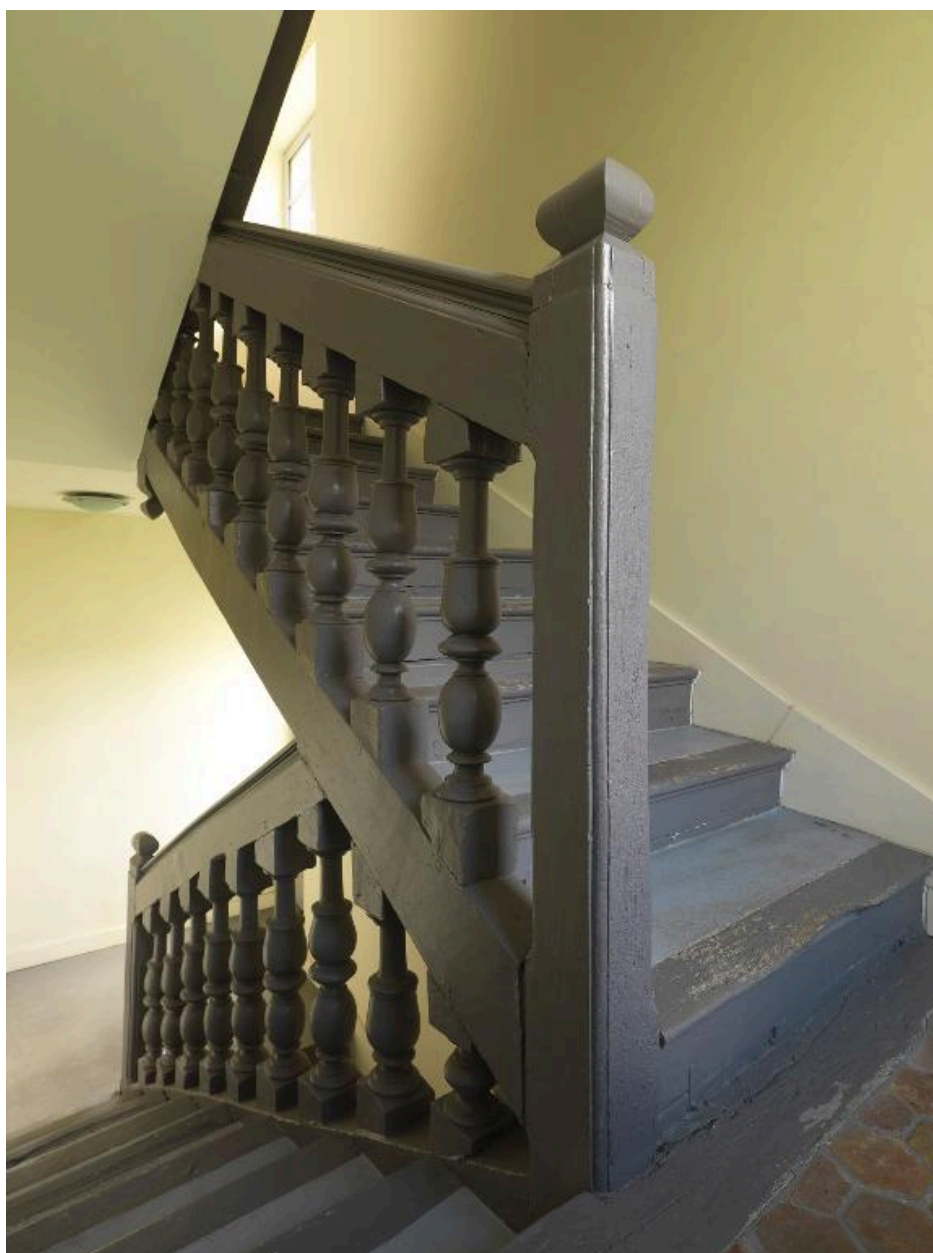
Détail des balustres en double poire de l'escalier.
