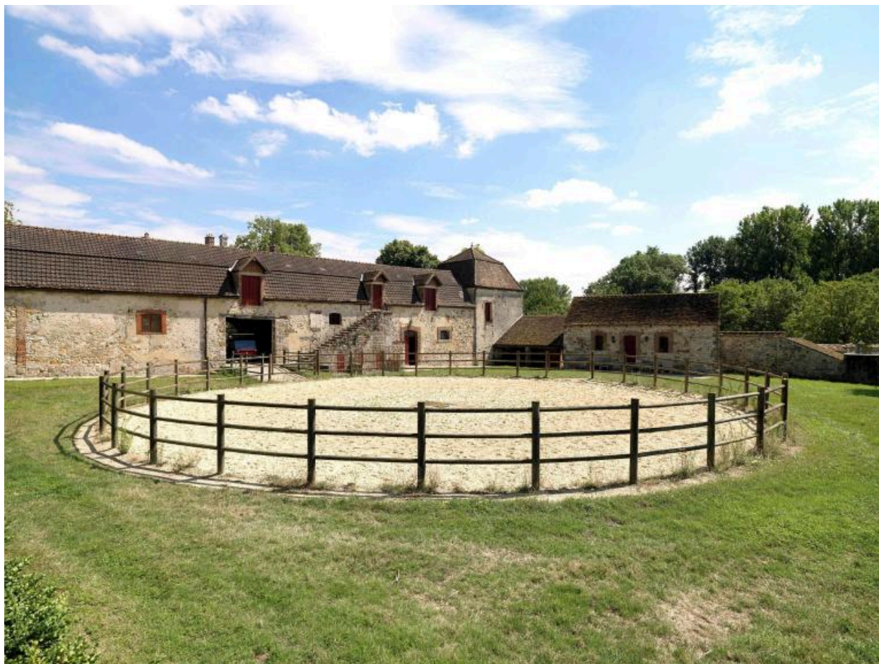
Vue sur le manège depuis le nord-ouest.
