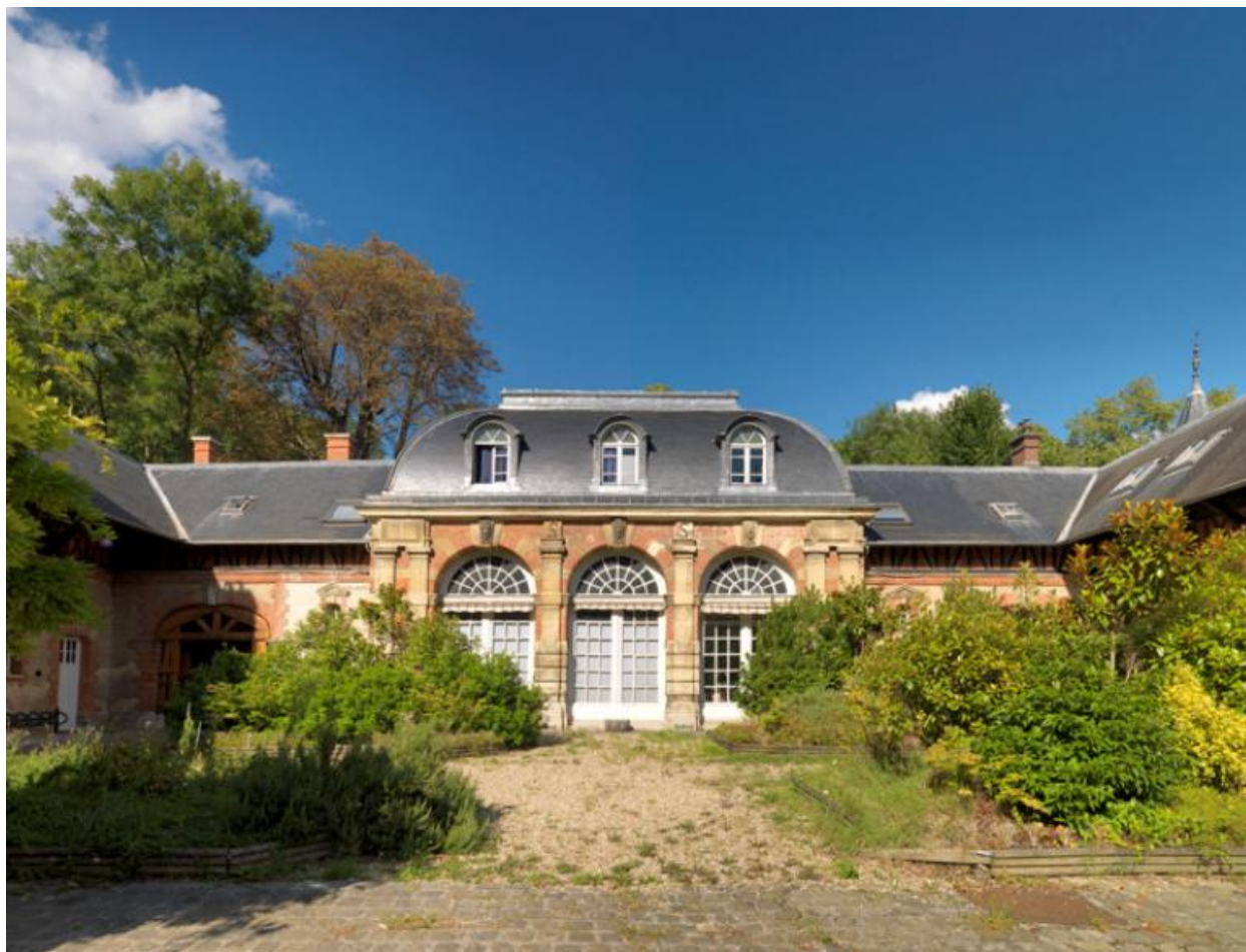
Partie centrale des communs : l'orangerie.
