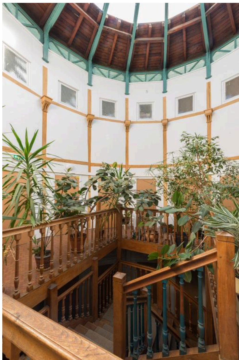
Vue de l'escalier et de la charpente métallique de la Rotonde
