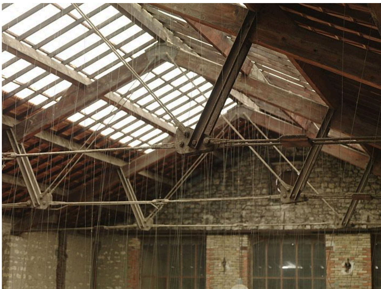
Charpente Polonceau de l'ancienne remise de voitures de la Compagnie des Tramways de Fontainebleau, depuis le nord.
