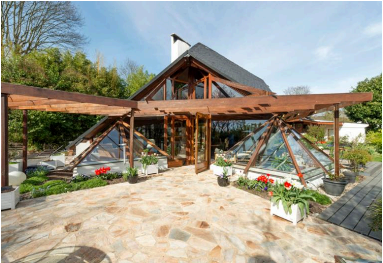
Vue de la façade latérale gauche : détail de la pergola de l'avant-corps Ouest.
