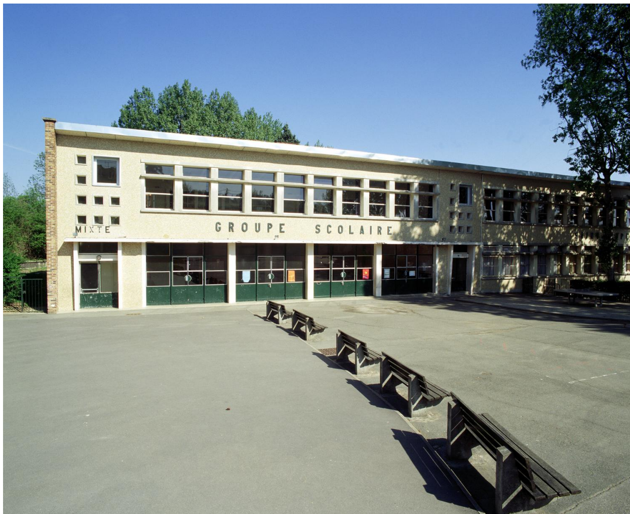
Vue de la façade est.
