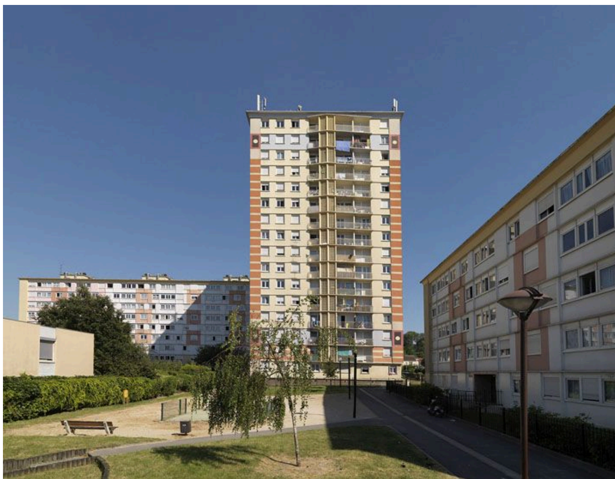
Cité Parat. Vue d'ensemble de la cité Parat, construite en 1962-1966, par P. Durand (architecte), rue du Docteur-Parat.
