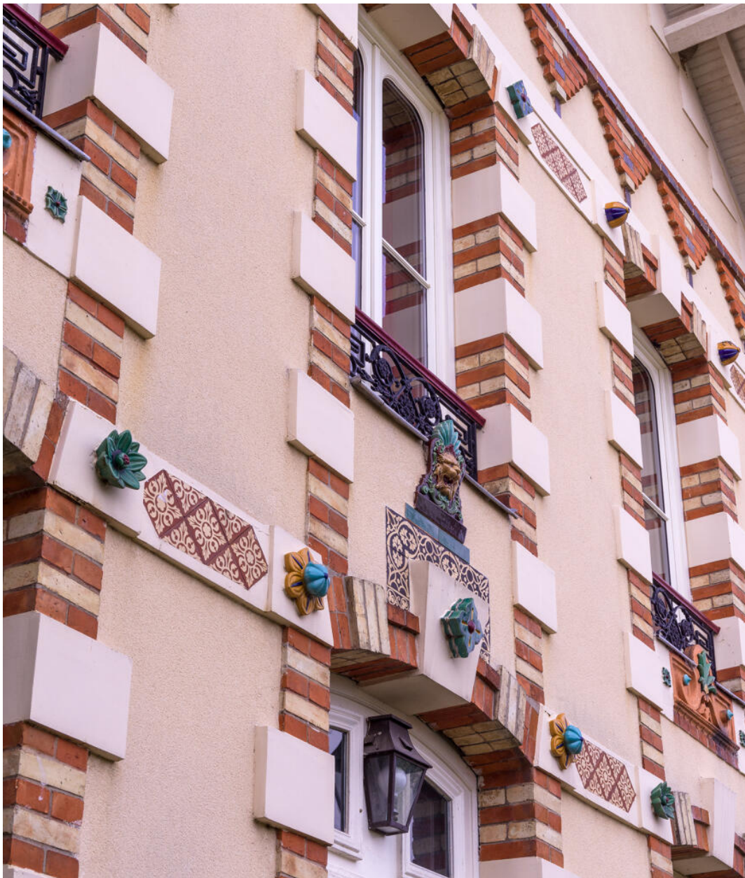
Vue de la façade nord, détail des décors.
