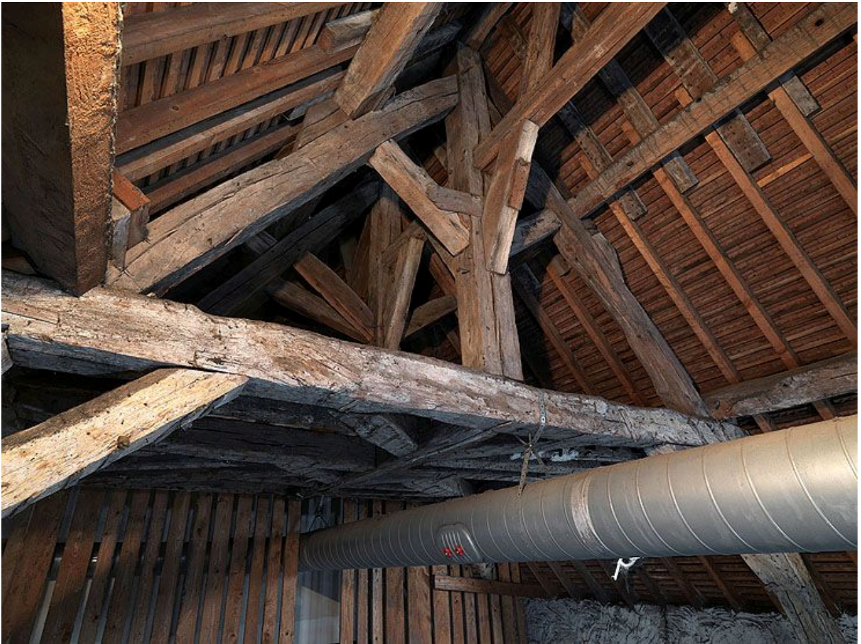
Charpente de l'aile nord, longeant la rue Saint-Remy.
