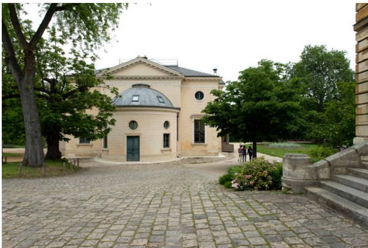
Elévation latérale gauche, vue générale prise de face.
