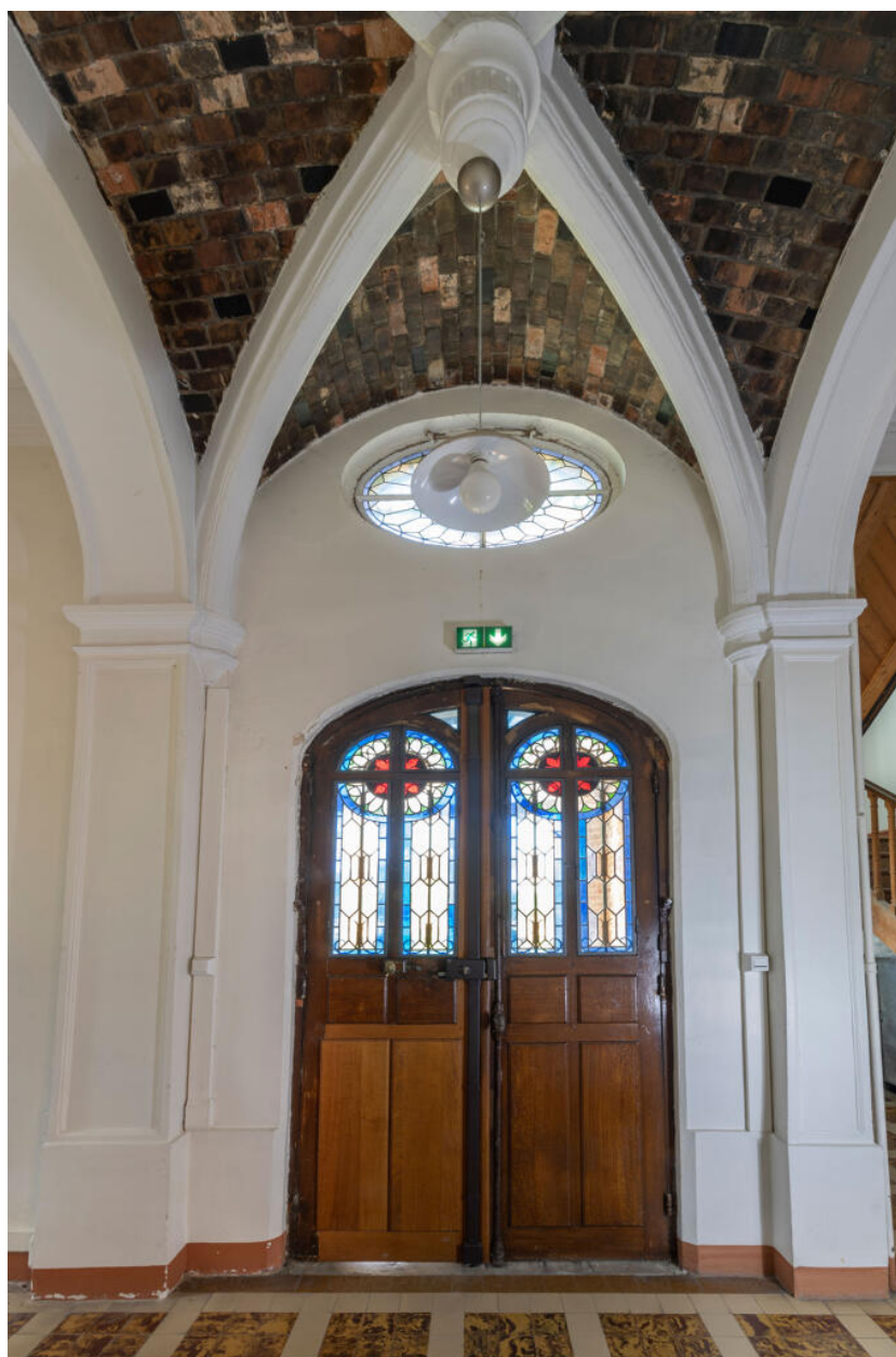
Le vestibule et la porte d'entrée.
