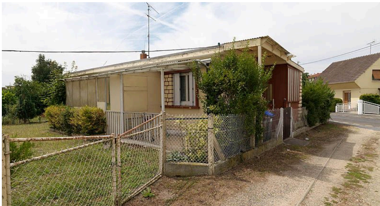
Maison individuelle, 28 rue du Pierris : vue depuis l'arrière.
