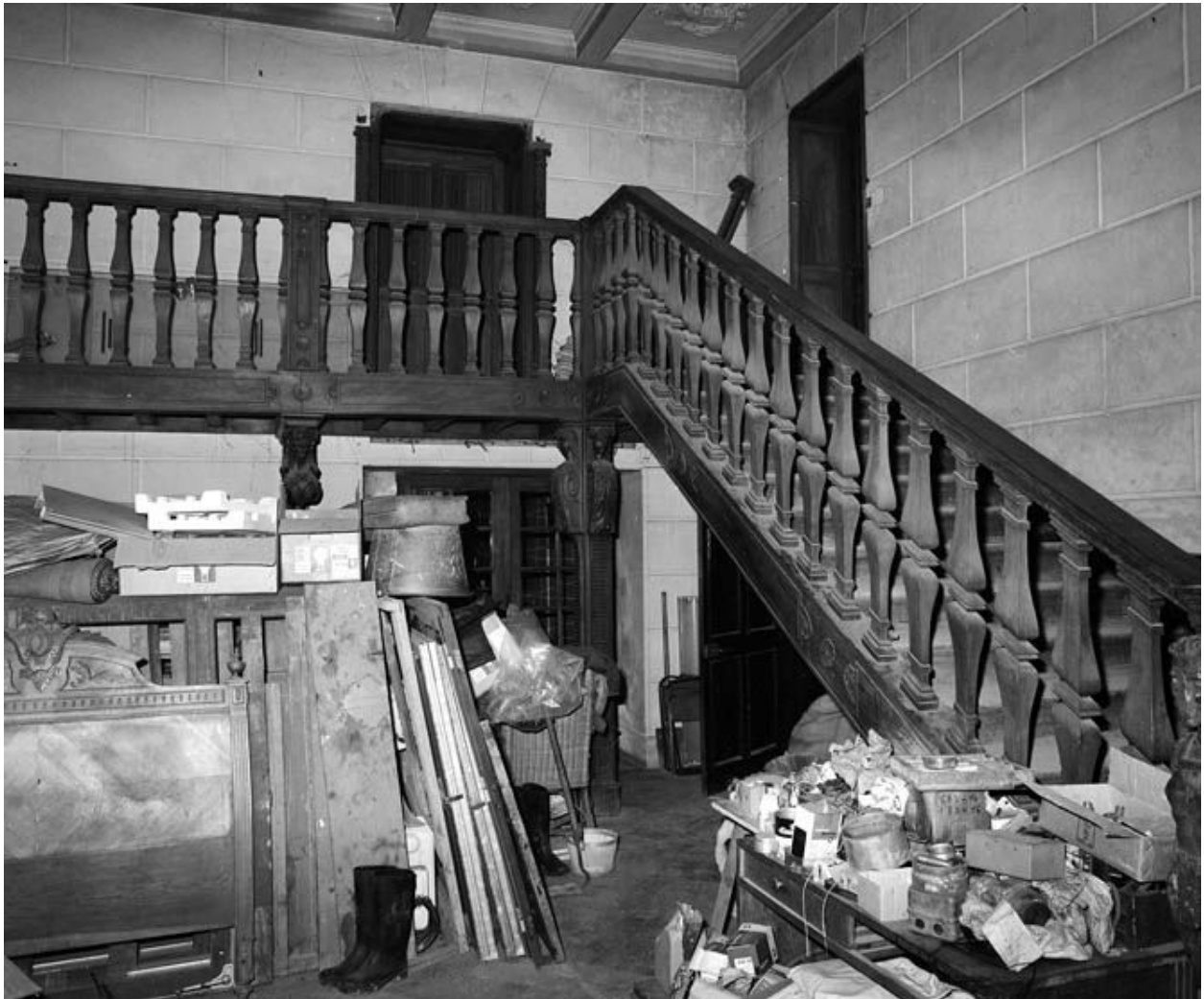
Vue de l'escalier intérieur. Cliché Pré-inventaire, 1974. (Région Ile-de-France, service patrimoines et inventaire, Cliché Pré-inventaire)
