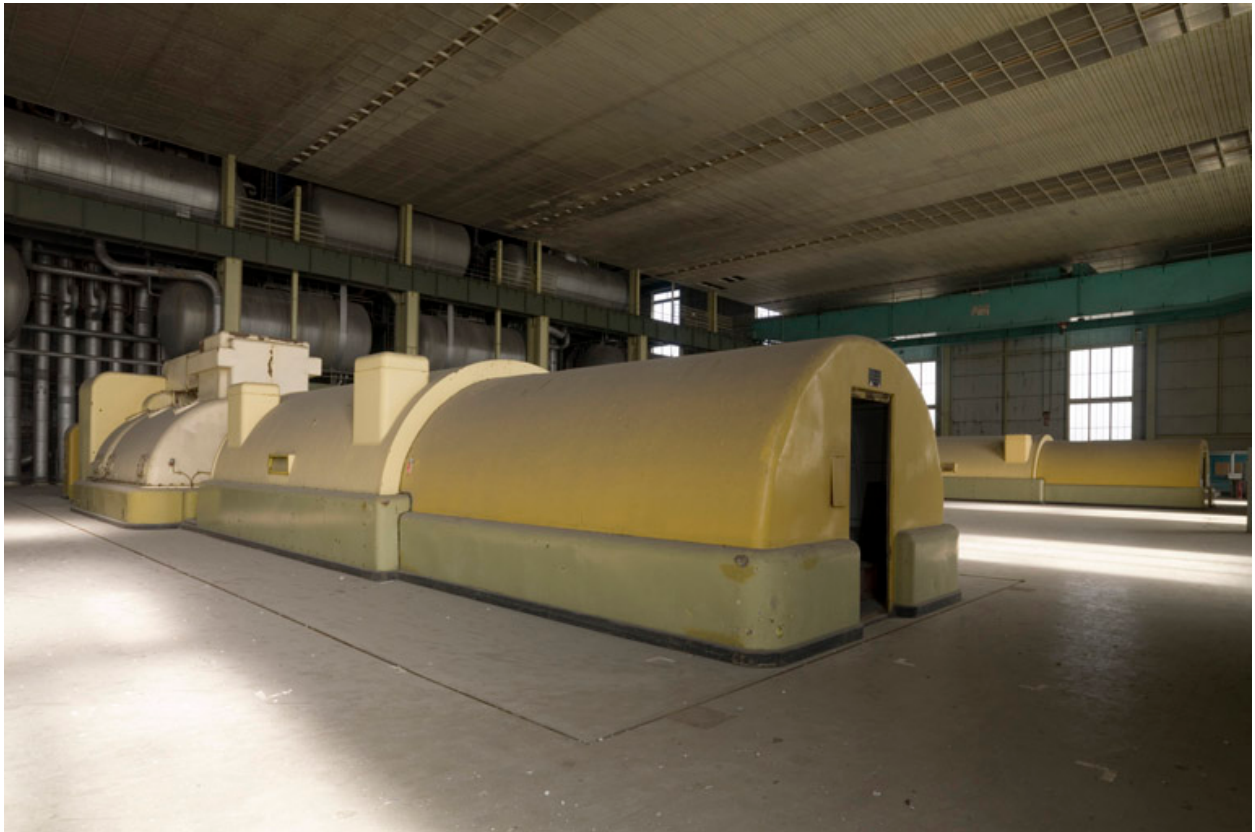
Poste d'eau tranche 125 MW. Turbine de contruction Alsthom.
