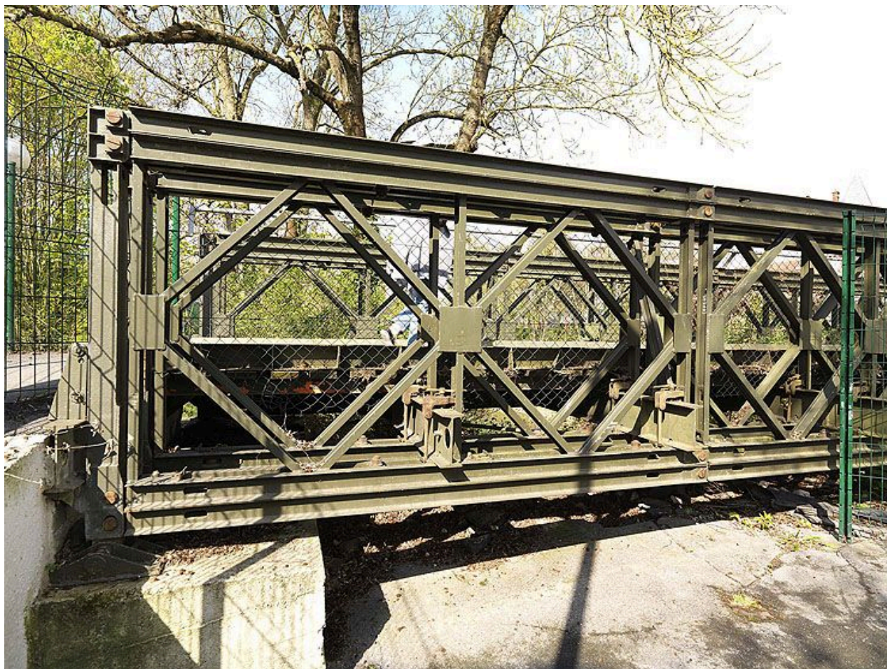
Les premières travées sud de la passerelle.
