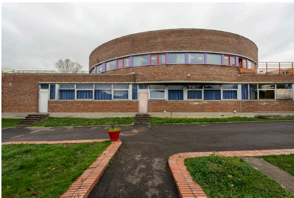
La maison sociale, au nord de l'établissement.
