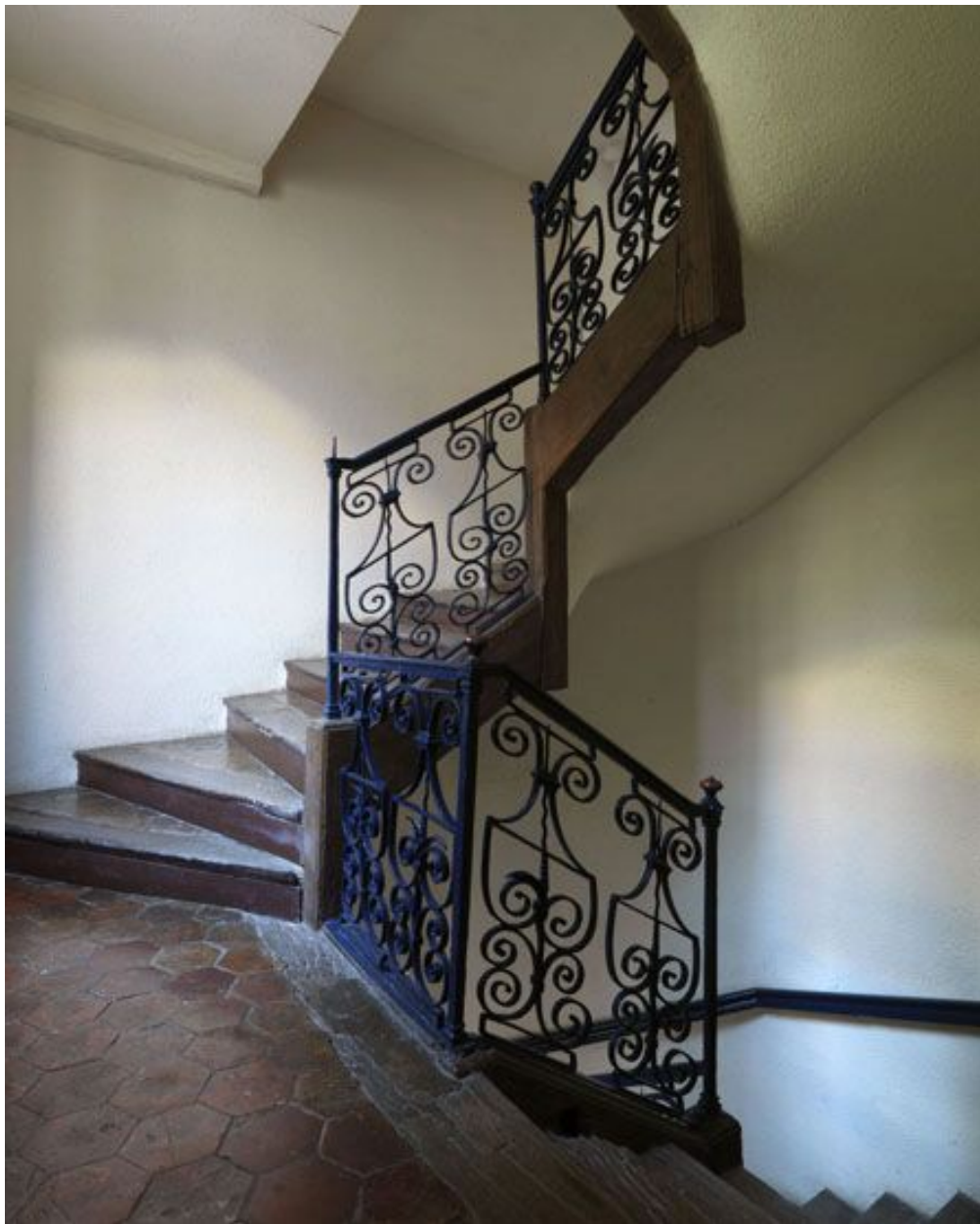
Vue des panneaux de la rampe à partir d'un repos.
