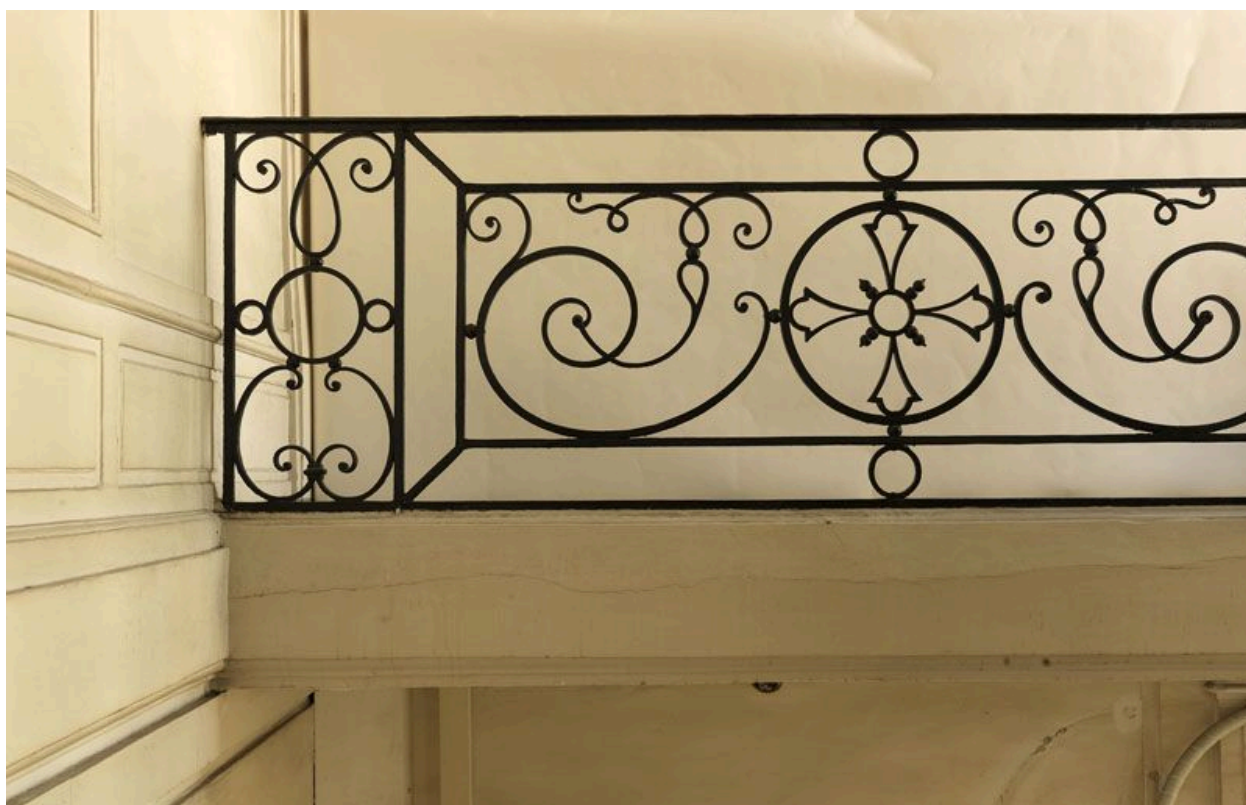
Le panneau droit du palier, 22 rue du Sentier.
