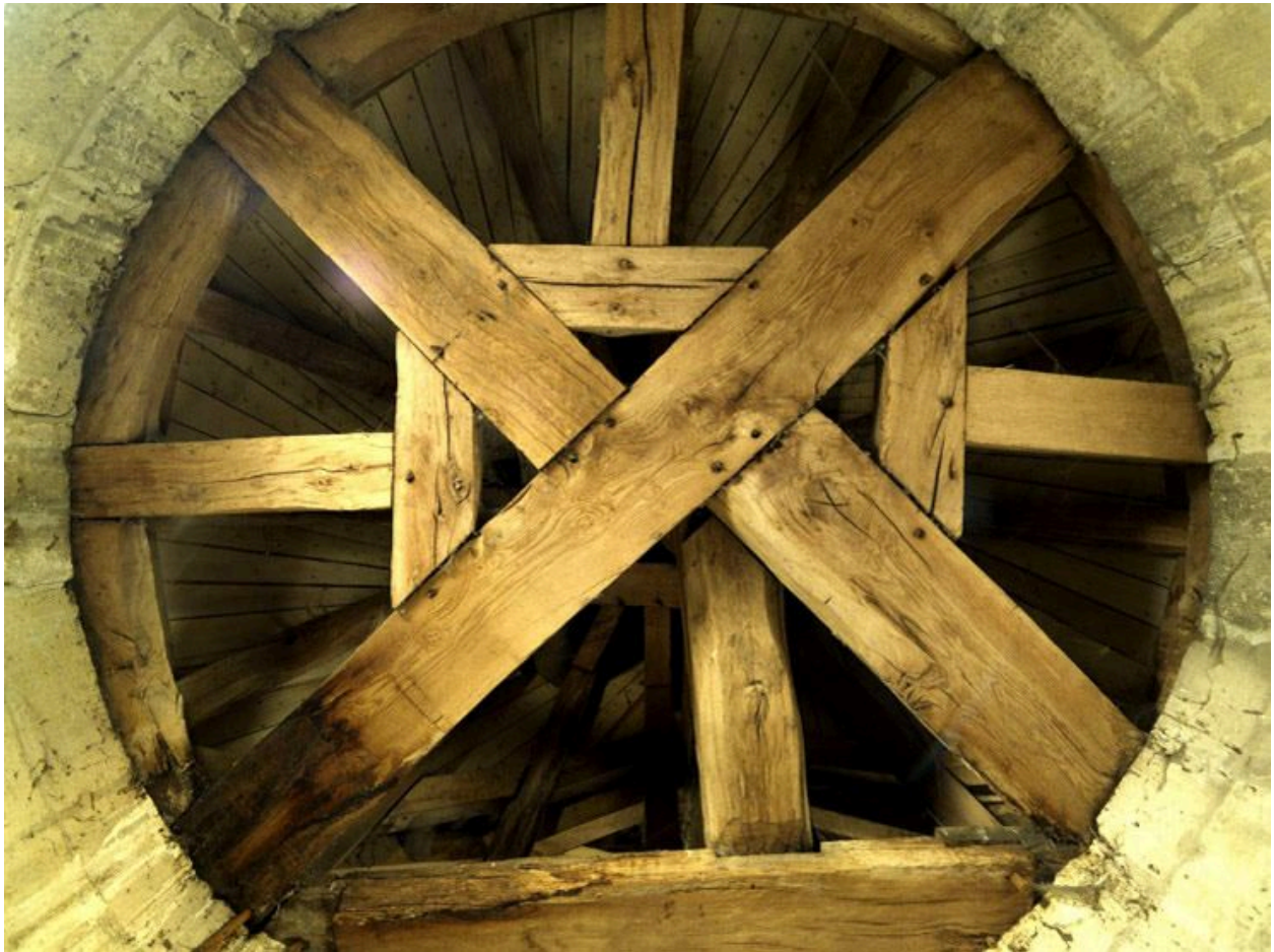
Enrayure d'une tourelle d'angle.
