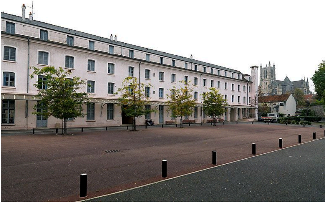
Aile sud de l'ancien séminaire : élévation sud (vue prise du sud-ouest, depuis la grande cour du lycée Henri Moissan).
