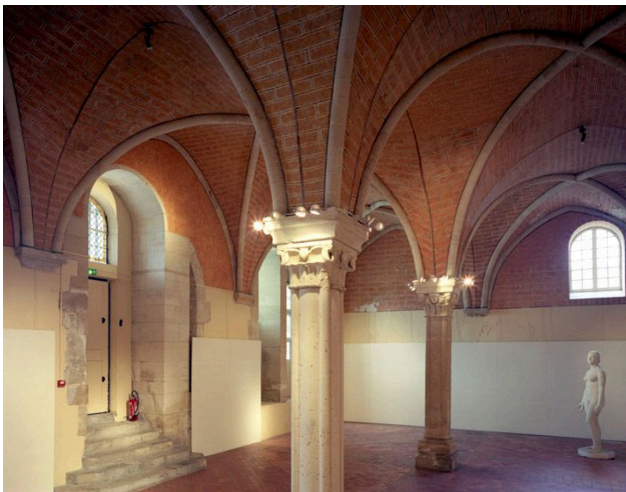
La salle basse orientale : vue de la partie nord-est, avec la sortie vers le jardin.
