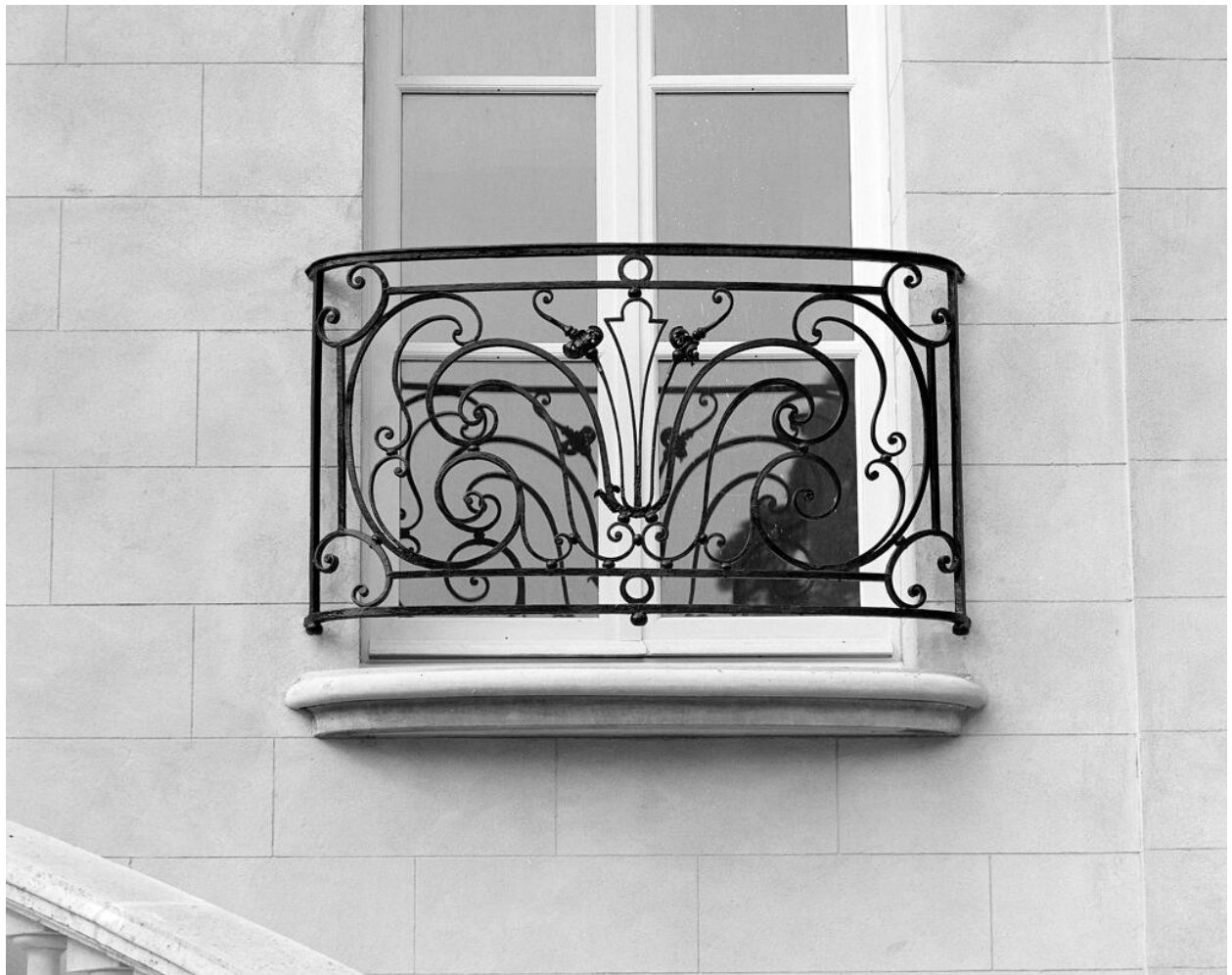
Détail d'un garde-corps en fer forgé.
